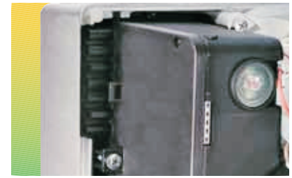
Ateşleme trafosu ile donatılmış kontrol kutusu
