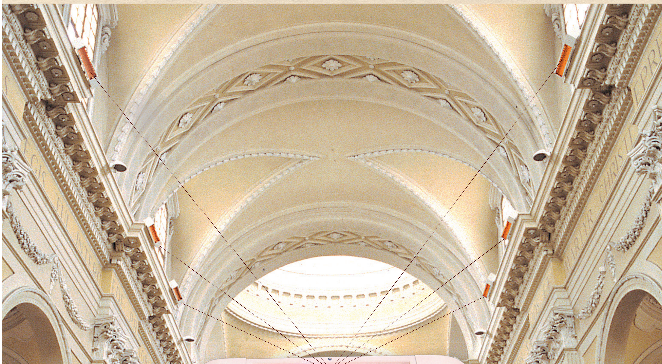
Impianto di irraggiamento SUNRAD presso la Basilica Metropolitana del Duomo di Ravenna
